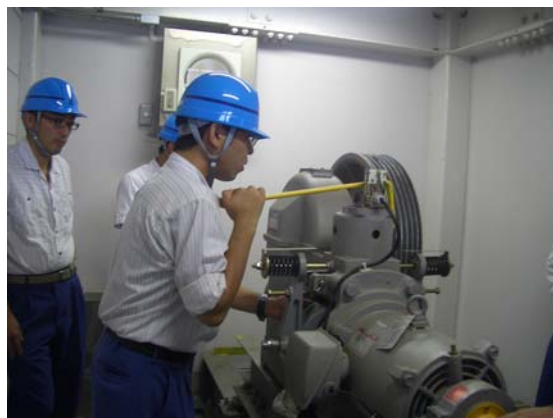
現場で機械設備の点検訓練を行う職員
